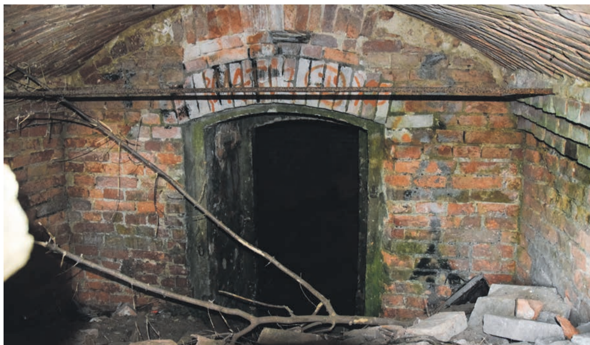
▲ Sklepienie bocznej komory lodowni przed laty się zawaliło. Pozwala to obejrzeć, jak dzięki odpowiedniemu ułożeniu cegieł możliwe jest utrzymanie potężnego ciężaru porośniętego drzewami dachu bez żadnego filaru. Odradzamy jednak próbę wejścia do środka, gdyż mogłoby okazać się to śmiertelnie niebezpieczne.
