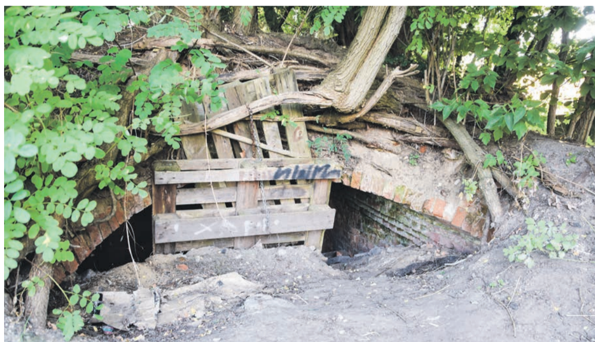
▲ Sklepienie bocznej komory lodowni przed laty się zawaliło. Pozwala to obejrzeć, jak dzięki odpowiedniemu ułożeniu cegieł możliwe jest utrzymanie potężnego ciężaru porośniętego drzewami dachu bez żadnego filaru. Odradzamy jednak próbę wejścia do środka, gdyż mogłoby okazać się to śmiertelnie niebezpieczne.
