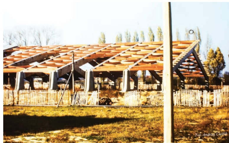
▲ Budowa obiektu ciągnęła się przez wiele lat. Fot. Andrzej Cieślak
