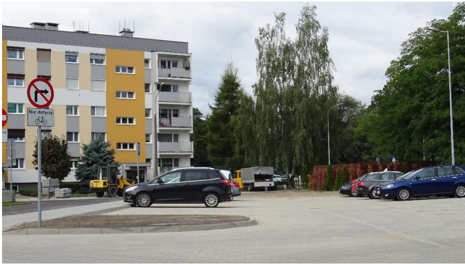
UL. 17 PUŁKU UŁANÓW, NOWY PARKING Z UZBROJENIEM
