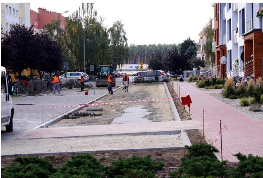
UL. REJTANA, ODCINEK ULICY W TRAKCIE REMONTU
