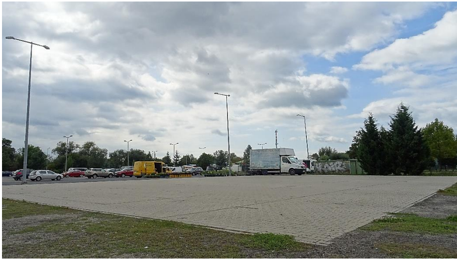
UL. HOLENDERSKA, UTWARDZONA POWIERZCHNIA HANDLOWA
