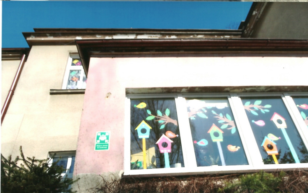
3. Opierzenie dachu i elewacja zewnętrzna
