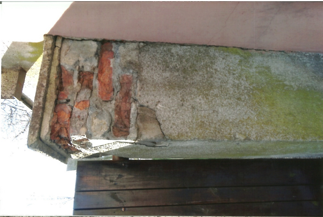
1. Murek przy bramie wjazdowej do przedszkola
