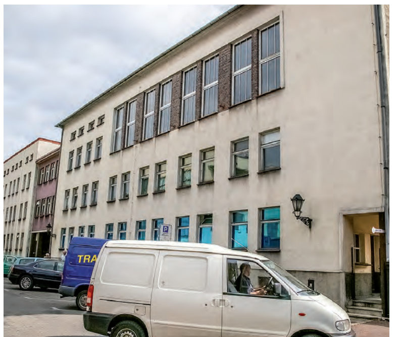
Fot. (2x) Archiwum E. Baldys ▲ Czerwiec roku 2008 - budynek dawnej fabryki cukierków Goplana, widok od ul. Królowej Jadwigi.
